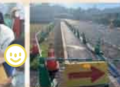
歩道ができます！ 事務所前～中高玄関の間
